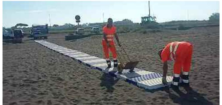
Iniziate il montaggio delle passerelle per i diversamente abili sulle spiagge libere di Campo di Mare. Operai della Multiservizi Caerite hanno già posizionato tre passerelle, sono le stesse dello scorso anno, hanno uno spessore di otto centimetri, un metro di larghezza e cinquanta metri di lunghezza. Le passerelle sono in PVC, un materiale con buone proprietà meccaniche e di resistenza all'abrasione, all'usura e all'invecchiamento, agli agenti
