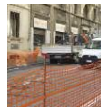
Coronavirus, nessuno slittamento dei cantieri stradali a Roma
