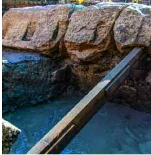
blocchi di travertino messi in opera a secco, fissati tra di loro mediante incavi rettangolari connessi a sporgenze dalle medesime caratteristiche e dimensioni, e rinforzati esternamente da uno spesso strato di cementizio. L'arcata è stata rinvenuta priva
