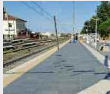
lavori ora si sono spostati sul binario 3 in direzione della Capitale, e si sta procedendo alla realizzazione dei plinti per l'installazione della pensilina, e i micropali per permettere l'installazione dell'ascensore che finalmente permetterà di raggiungere tutti i binari anche alle persone con ridotta mobilità o ai diversamente abili. Entro il mese di novembre arriveranno le pensiline mentre l'elevatore sarà posizionato a dicembre.
