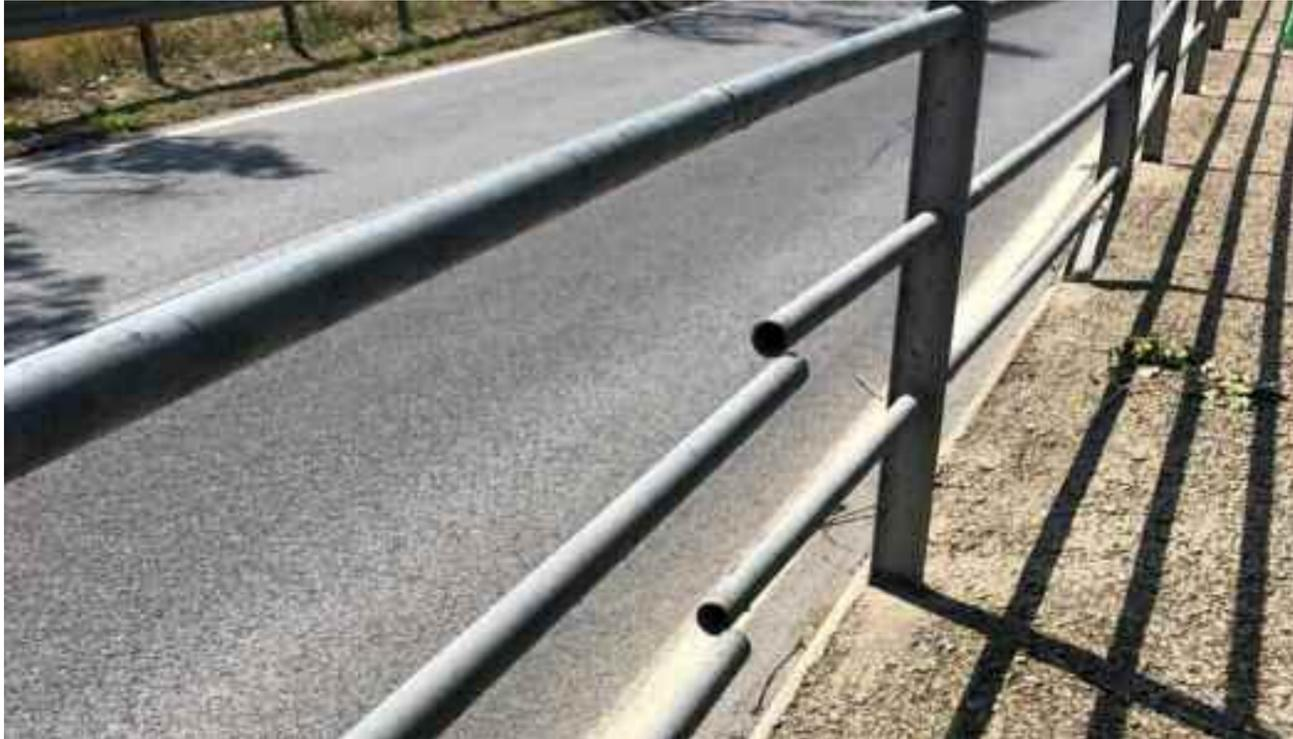
ferrovia dai binari della stazione ferroviaria sottostante. Il muretto è ammalorato. La barriera è «troppo corta» non a completa copertura del tratto interessato. Non si esclude dunque il pericolo che «qualcuno possa commettere qual-
