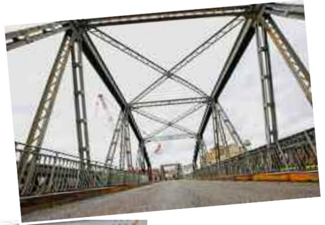
ciclisti. A seguito dell'incendio del 2021, dopo le indagini del Dipartimento Csimu, il ponte è stato riaperto in via provvisoria, consentendo il transito a esclusione dei veicoli con carico superiore a 3,5 tonnellate. Nel rispetto della normativa vigente, il ponte sarebbe rimasto transitabile solo per successivi 5 anni. Quindi - conclude Segnalini - senza l'intervento strutturale, come quello in atto, la chiusura definitiva sarebbe stata nel 2026".
