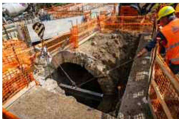
zioni di demolizione del primo collettore e alla costruzione del nuovo collettore scatolare, Anas ha iniziato la realizzazione dei pali che consentono il sostegno del nuovo
